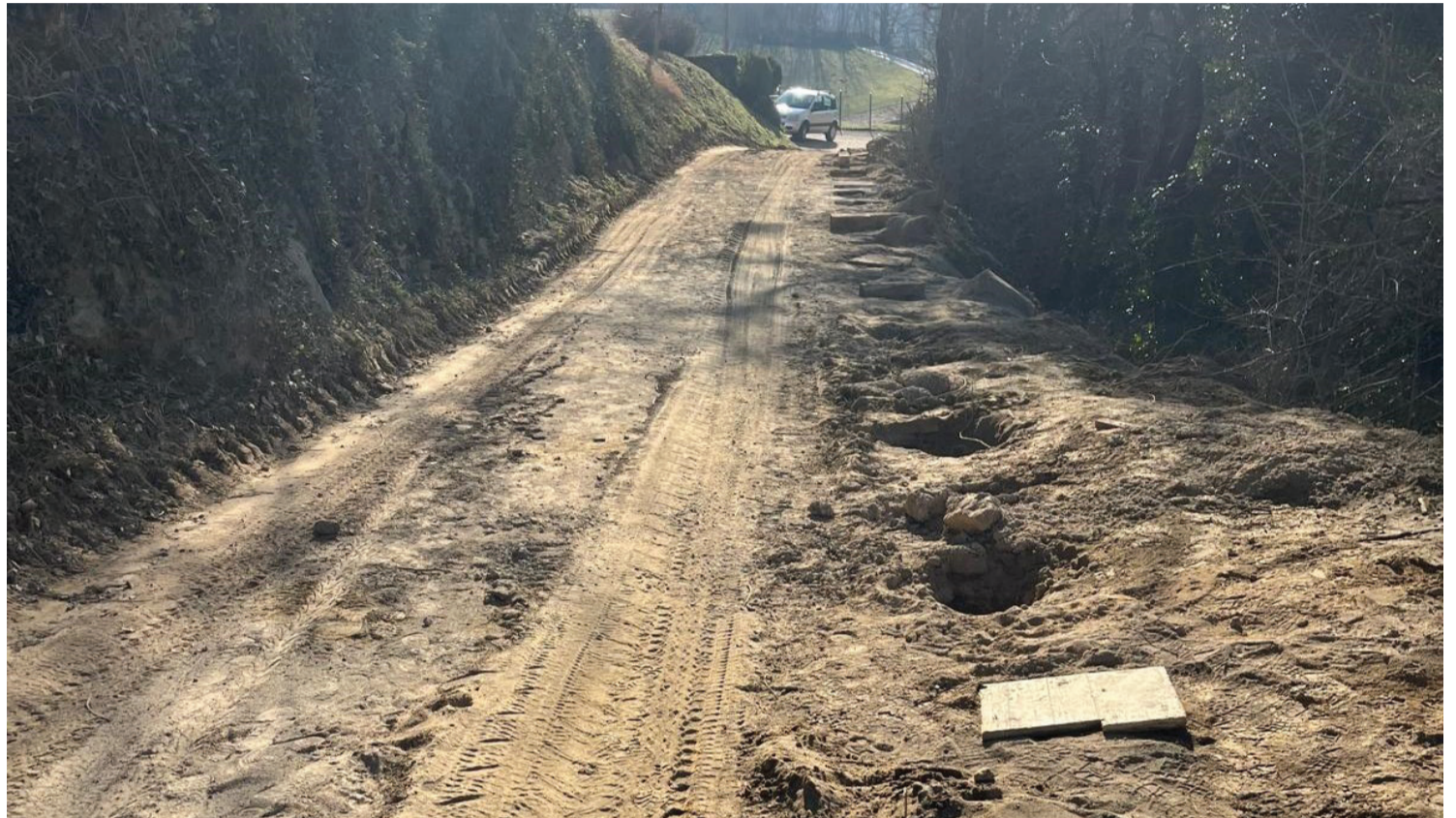
Pri kraju je sanacija klizišta na lokalnoj nerazvrstanoj cesti na području Gornjeg Jesenja. Radi se o lokalitetu Pečina Kostanjek, gdje se provode radovi pilotiranja i sanacije stijene koja je na kliznoj površini
