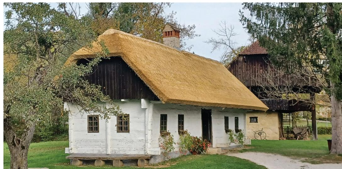
Snopove se za ovu vrstu pokrova ne izrađuje strojno, nego se slama ručno mlati i slaže u 'šopice'
