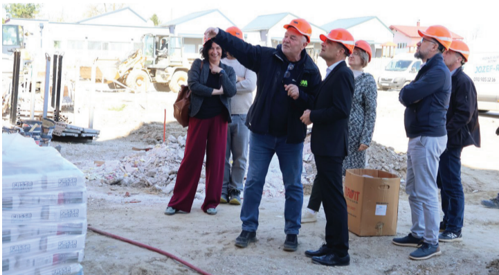
Rekonstrukcijski radovi počeli su 23. siječnja 2025. godine i trenutačno su u završnoj fazi
