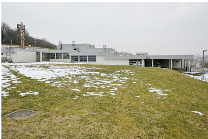
Dograđena dvorana uz PŠ Remetinec imat će više od 324 četvorna metra, a sadržavat će prateće prostore poput svlačionica, sanitarnih čvorova i spremišta za sportsku opremu
