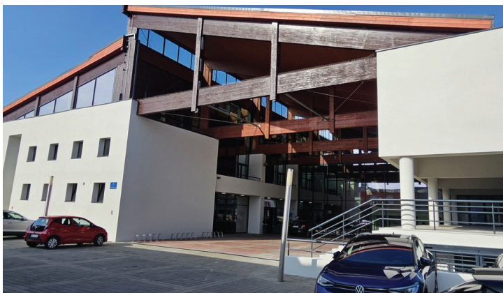
Posebno je svečano bilo prvog dana nastave u Gospodarskoj školi Čakovec, koja je učenike dočekala u novom ruhu zahvaljujući energetskej obnovi, vrijednoj 2.920.099,50 eura
