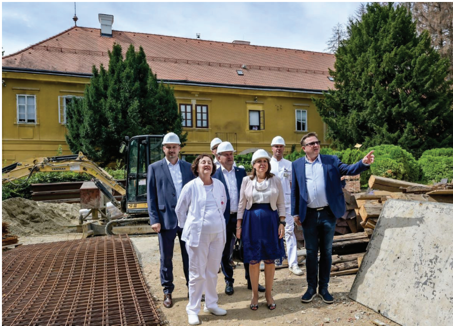
...te radove na obnovi bolnice u Novom Marofu
