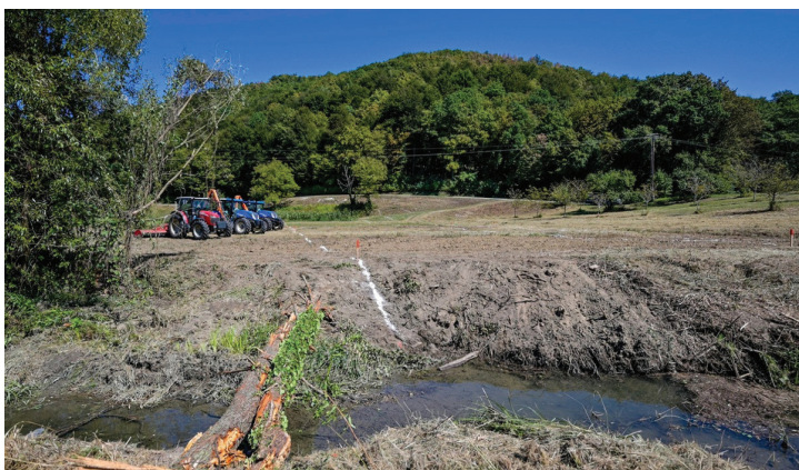
Radovi se izvode u slivu vodotoka Kamenica, lijevog pritoka rijeke Bednje. Cilj zahvata je prihvatanje velikih vodnih valova i zaštita od poplava nizvodnog područja
