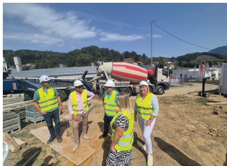
Građevinske radove izvodi tvrtka 'Kaj Lux d.o.o.', dok će se nabava za opremanje provesti ove jeseni
