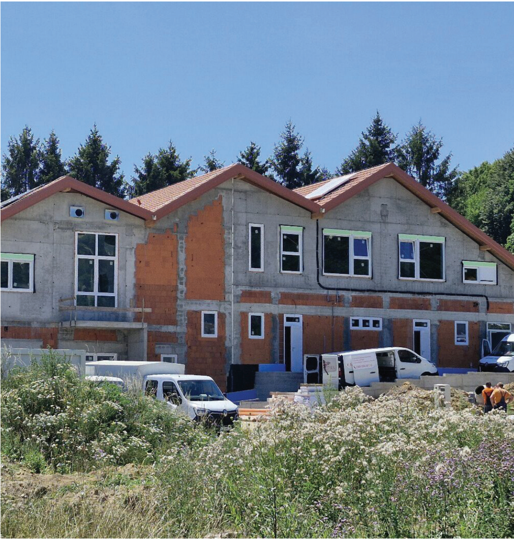
Radovi na izgradnji 2,4 milijuna eura vrijednog područnog vrtića u završnoj su fazi i bit će završeni do kraja listopada. Vrtić će moći primiti 64 djece odnosno četiri vrtičke skupine
