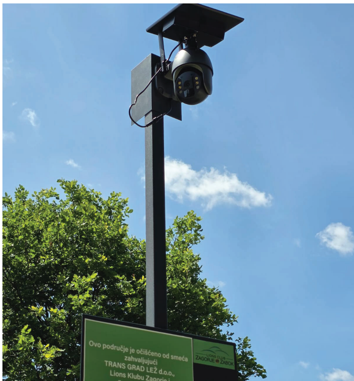
Nakon što je teren očišćen, postavljena je moderna solarna kamera s 360° nadzorom i 24-satnim prijenosom u stvarnom vremenu
